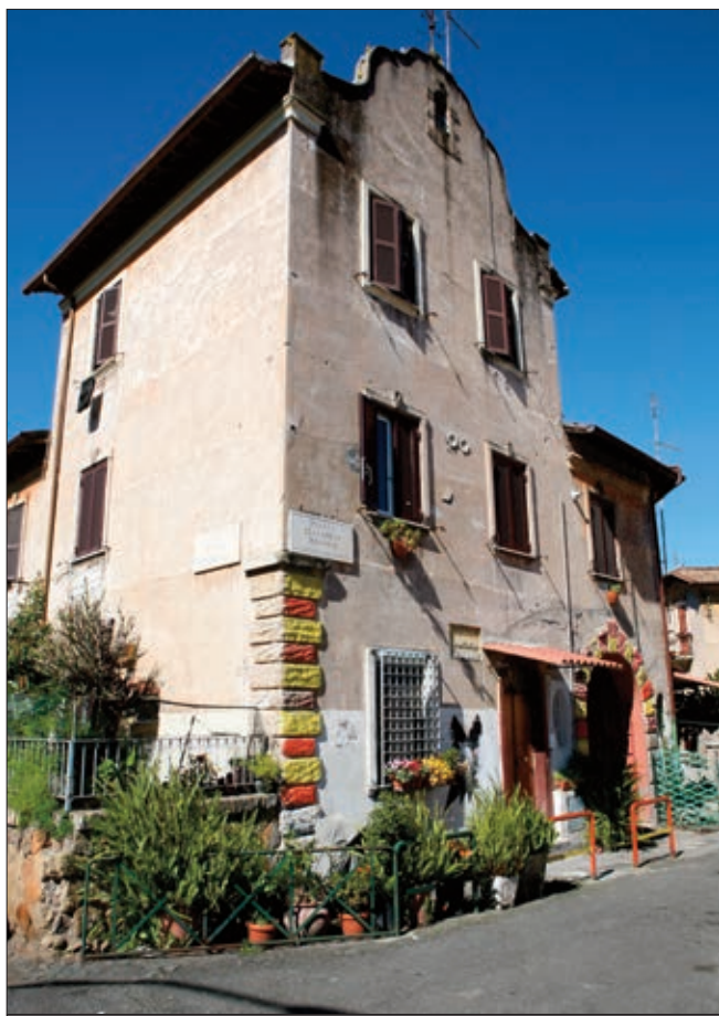
La caratteristica palazzina a piazza Masdea
