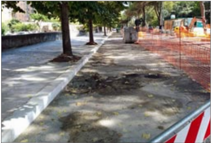
Manutenzione straordinaria marciapiedi viale Giustiniano Imperatore
